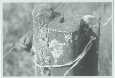
Umfunktionierte Eisenbahnschiene aus der Mitte des 19. Jahrhunderts: Einer der beiden als Brückenschienenstücke identifizierten Zaunpfosten im Rossmad bei Haag. Bild 2001: Hans Jakob Reich, Salez.
