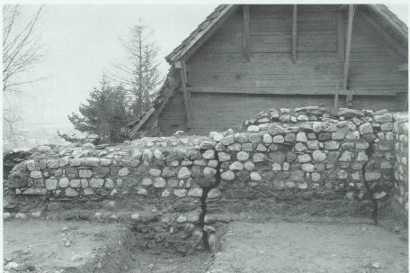
Abb. 8. Auswirkungen eines Erdrutsches, möglicherweise durch ein Erdbeben ausgelöst: Die im Bereich der Türschwelle auseinander gerutschte und abgesackte Ostmauer (oben, Bildmitte). 7 bis 30 Zentimeter breite Vertikalrisse durchziehen die gesamte Dicke der Ostmauer (unten).
