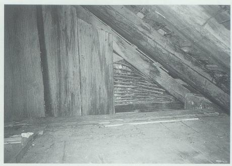
Wandausfachung in Rutengeflecht mit Lehmverputz unter einem Dachstuhl von 1654. Diese unscheinbaren Konstruktionselemente sind nicht nur Zeugen der altertümlichen Bauweise, sie lassen sich in der Regel auch ohne weiteres an Ort erhalten. Sogar eine Verkleidung derselben ist meist der geeignetste Weg, diese Befunde unseren Nachfahren zu überliefern.
