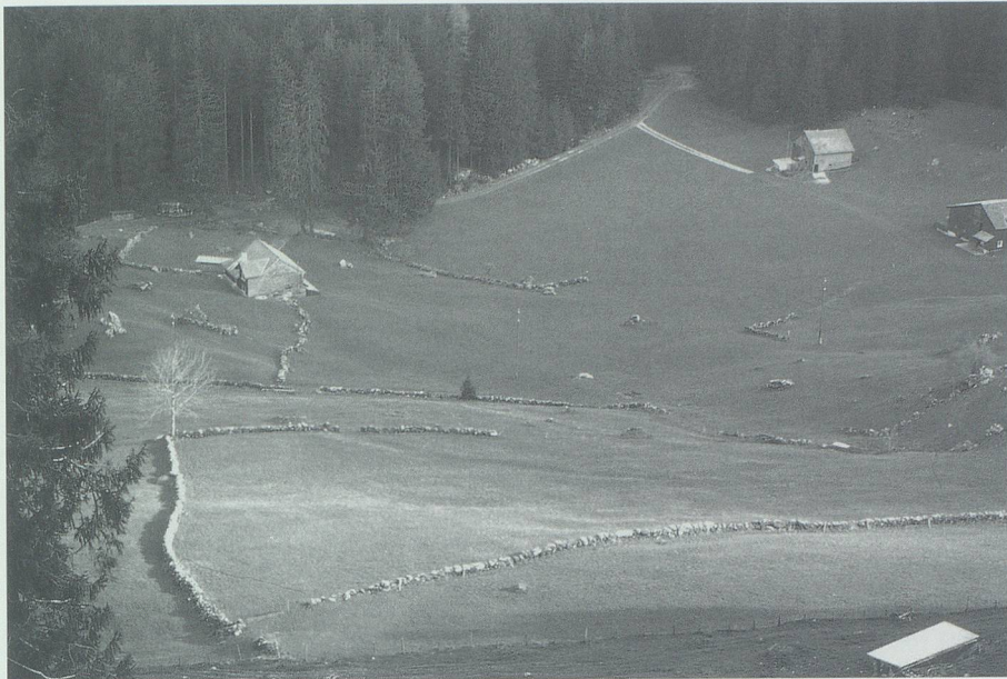
Das Trockenmauersystem in Leversschwendi gibt dieser Geländekammer ihren Reiz. Leider ist ein Teil der Mauersubstanz schon anderweitig verwendet worden. Bild 1998.
