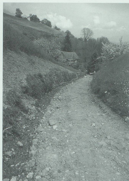
Im unteren Bereich der Chüegass sind die seitlichen Stützmauern infolge von Grabungsarbeiten verschwunden. Der Mangel an Zeit und Geld hat wohl dazu geführt, dass die Herstellung des ursprünglichen Zustandes unterlassen wurde. Bild 1998.
