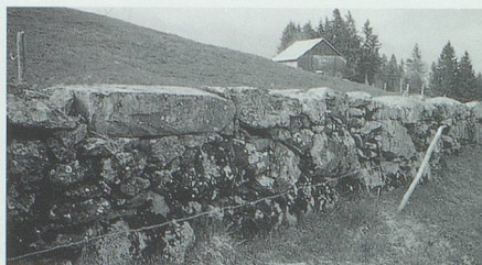
Währschafte Trockenmauern wurden abgeschlossen mit einer Krone aus «gestellten» Steinen (links) oder dann mit liegenden Deckplatten (rechts), welche ein ansehnliches Gewicht aufweisen können. Die Mauern stehen im Raum Flammer bzw. Pilärsch. Bilder 1998.
