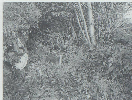
Teile des Projektabschnitts Buechengass, wie sie sich vor der Restaurierung präsentierten: Die seitlichen Stützmauern sind eingefallen und beeinträchtigen die Wegsohle. Weiter oben ist wegen der starken Bestockung ein Durchkommen kaum mehr möglich. Bilder 1998.
