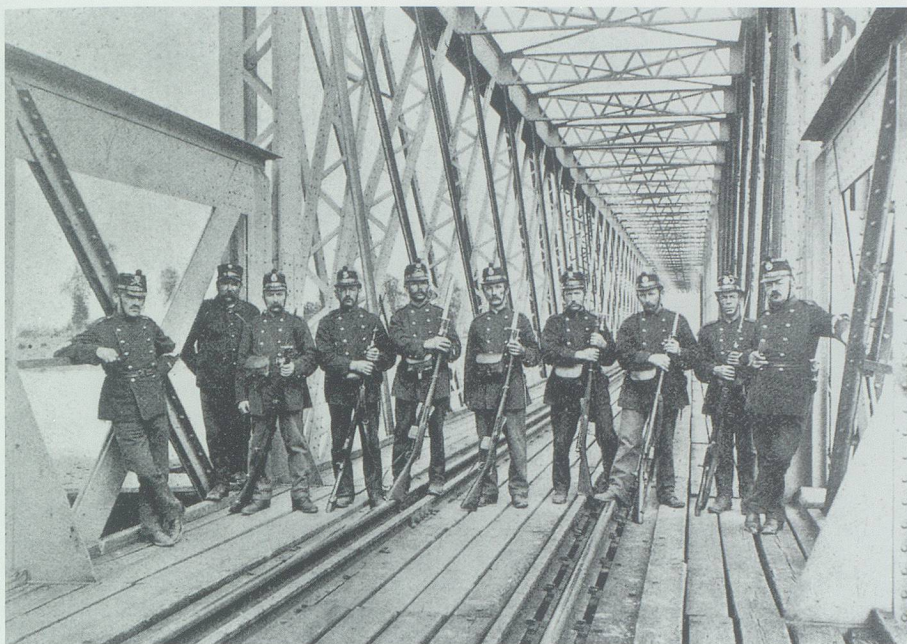
Grenzbesetzung im Kriegsjahr 1914: Schweizer Landsturmsoldaten bewachen die Eisenbahnbrücke bei Buchs. Bild im Archiv Hansruedi Rohrer, Buchs.
