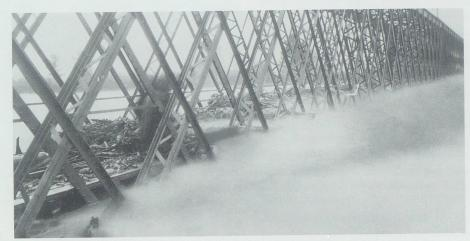
25. September 1927: Die zu tief liegende Eisenbahnbrücke behinderte den Durchfluss des Hochwassers. Der Damm wurde überflutet, was innert Kürze zum Dammbruch führte. Bild aus Rheinnot 1977.
