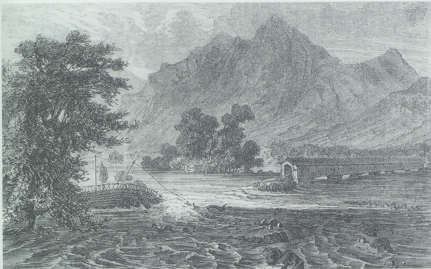
Schon beim ersten Hochwasser von 1868, jenem vom 27./28. September, wurde bei der Rheinbrücke von Ragatz der Bahndamm von den Fluten der Tamina weggespült; die Brücke selber blieb verschont. Bild aus «Leipziger Illustrierte Zeitung», 1868.
