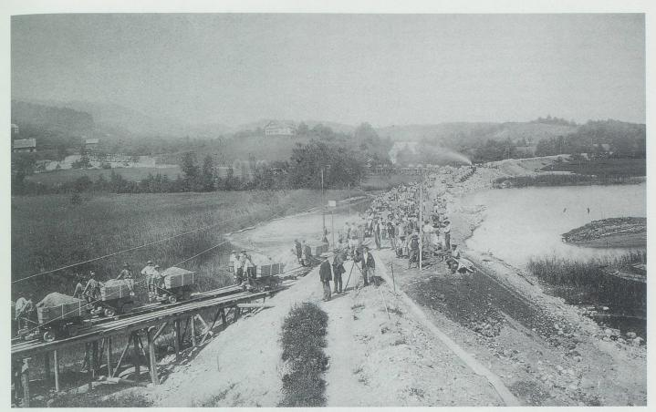
Die ersten Bahnanlagen waren äusserst einfache Trassees, welche in Handarbeit erstellt wurden. Fotografie von einer Baustelle im Mittelland, vermutlich in den 1870er Jahren, als bereits Materialbahnen eingesetzt wurden. Bild aus Bahnsaga 1996.
