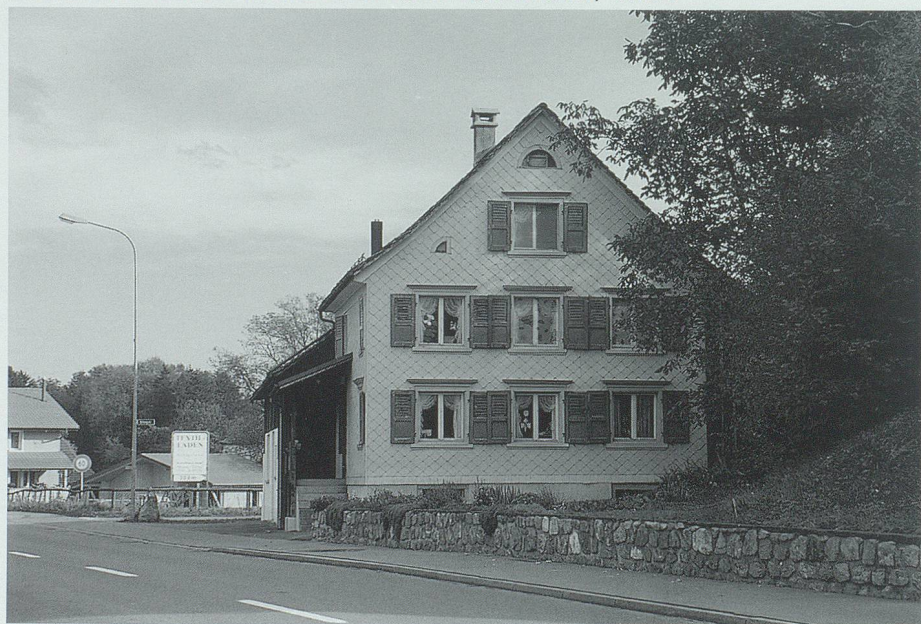
Eines der drei vom Stüdle ins Unterdorf versetzten Häuser: das Haus «s Chüefers» bei der Kirche. Bild: Hans Jakob Reich, Salez.
