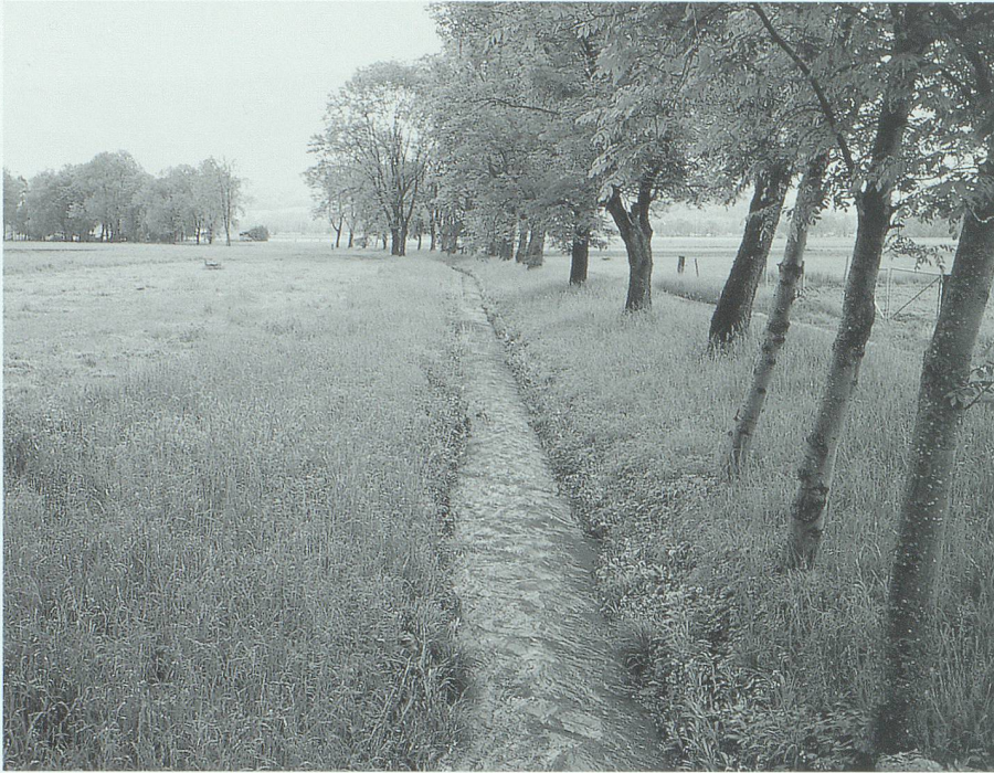
Vom Kanal zum Bach: Der schnurgerade Entsumpfungskanal vor der Renaturierung...
