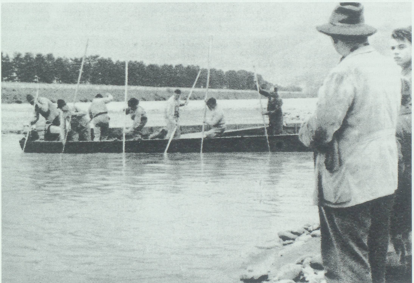
Suche nach den Vermissten etwa zwei Kilometer unterhalb der Unfallstelle. Eines der Opfer wurde am 6. August unterhalb der Brücke Haag-Bendern auf der liechtensteinischen Seite des Rheins von einem Fischer entdeckt. Bild aus «Das gelbe Heft» vom 28. Juli 1956.
