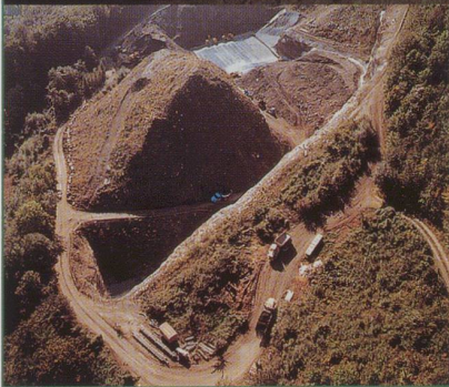
Schlackendeponie Steinbruch Buchserberg
