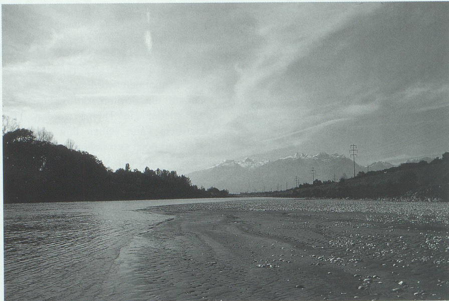
Kraftwerkbauten am Rhein werden kaum wieder zu einem Thema – über Renaturierungsmöglichkeiten kann ohne technische Sachzwänge nachgedacht werden.
