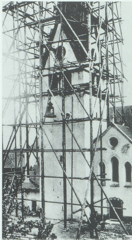
Umbau des Glockenturms der alten evangelischen Kirche Grabs im Jahr 1917. Bild 1917. Im Archiv Hansruedi Rohrer, Buchs.
