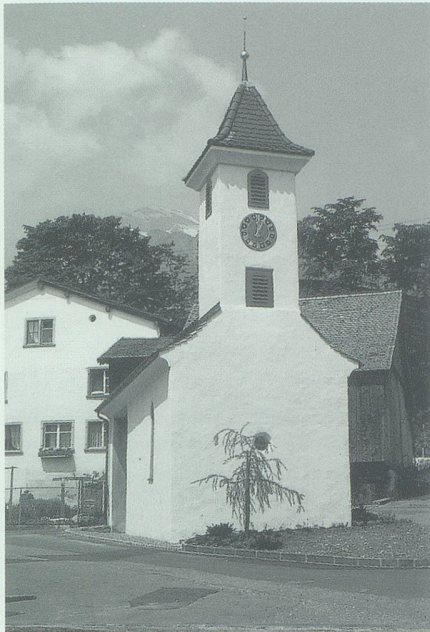
Kapelle St. Erasmus in Fontnas. Der biedermeierliche Turmaufbau über dem ehemaligen Chörlein geht auf den 1821 veranlassten Wiederaufbau der Kapelle nach den Dorfbränden von 1816 zurück. Der schlichte Turmstock, bündig aus der geraden Chorschlusswand wachsend, wird gegliedert durch Zifferblatt und mit Rundbogen abgeschlossenen Schallöffnungen. Die Bekrönung bildet ein pyramidenförmiges Turmdach. Bild: Albin Fraefel.
