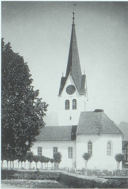
Der schlichte, im Verhältnis zur Kirche aber dennoch übergrösse Glockenturm der alten evangelischen Kirche Grabs zeigte bis 1917 allseitig gedoppelte Schallöffnungen mit Rundbogenabschlüssen, je überfangen von einem Zifferblatt. Die steil aufsteigenden Uhrengiebel führten über in den spitzen Turmhelm. Bild vor 1917. Im Archiv Hansruedi Rohrer, Buchs.
