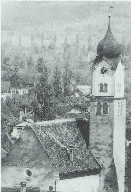
Charakteristisch für die alte evangelische Kirche Buchs und gleichsam deren Visitenkarte war der Turmabschluss, der aus einer barocken Zwiebelhaube über vier geschweiften Uhrengiebeln bestand. Dieser Turmabschluss, häufiger anzutreffen bei katholischen Landkirchen der Alten Landschaft zwischen Rorschach und Wil, stellte im Werdenberg ein Unikum dar. Bild 1920er Jahre. Im Archiv Hansruedi Rohrer, Buchs.
