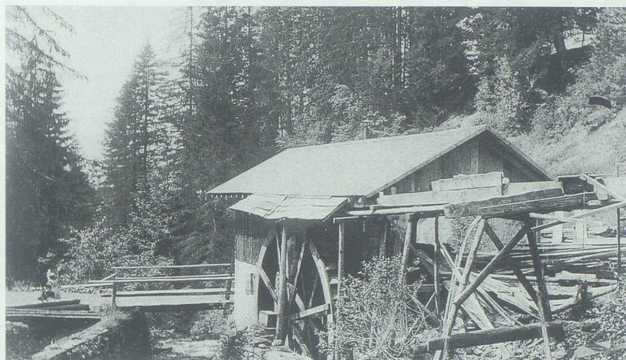
Sägemühle mit überschlächtigem Wasserrad und Kett, um 1900; Standort unbekannt. Bild bei Hans Senn, Weite.
