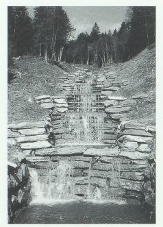
Mit den vorhandenen Steinen, neuen Hölzern und einem Schreitbagger anstelle von ausschliesslicher Menschenkraft 1992 erstellte, sanierte Treppenstufen im Trüebbach. Bild: Eugen Henauer, Buchs.
