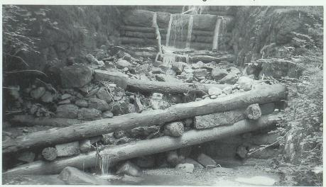
Anzeichen einer Geländeverschiebung in einer Blockmauer im Trüebbach. Bild: Eugen Henauer, Buchs.
