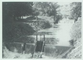
Kiessammler mit Schleusen und einem Nachbecken als Kolkschutz verhindern den Eintrag von Material aus der Simmi in den Binnenkanal. Bild: Eugen Henauer, Buchs.
