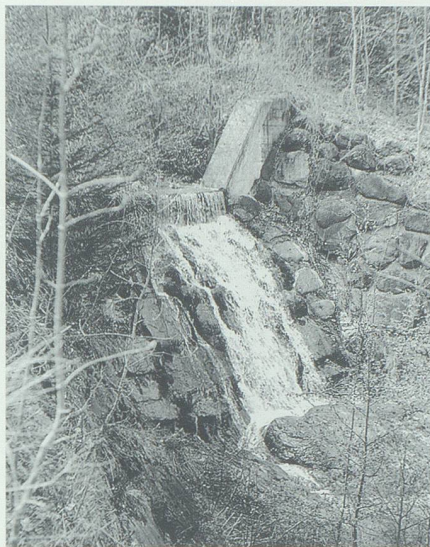
Kolkschutz (Energievernichter) nach einer Betonsperre im Walchenbach, Grabs. Bild: Eugen Henauer, Buchs.
