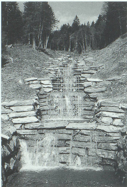
Mit den vorhandenen Steinen, neuen Hölzern und einem Schreitbagger anstelle von ausschliesslicher Menschenkraft 1992 erstellte, sanierte Treppenstufen im Trüebach. Bild: Eugen Henauer, Buchs.
