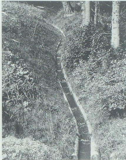
Lokale Wasserableitung mit Holzkänneln am Felsbach, Gams. Gut gebaut, stabilisieren sie das Gelände. Bild: Eugen Henauer, Buchs.
