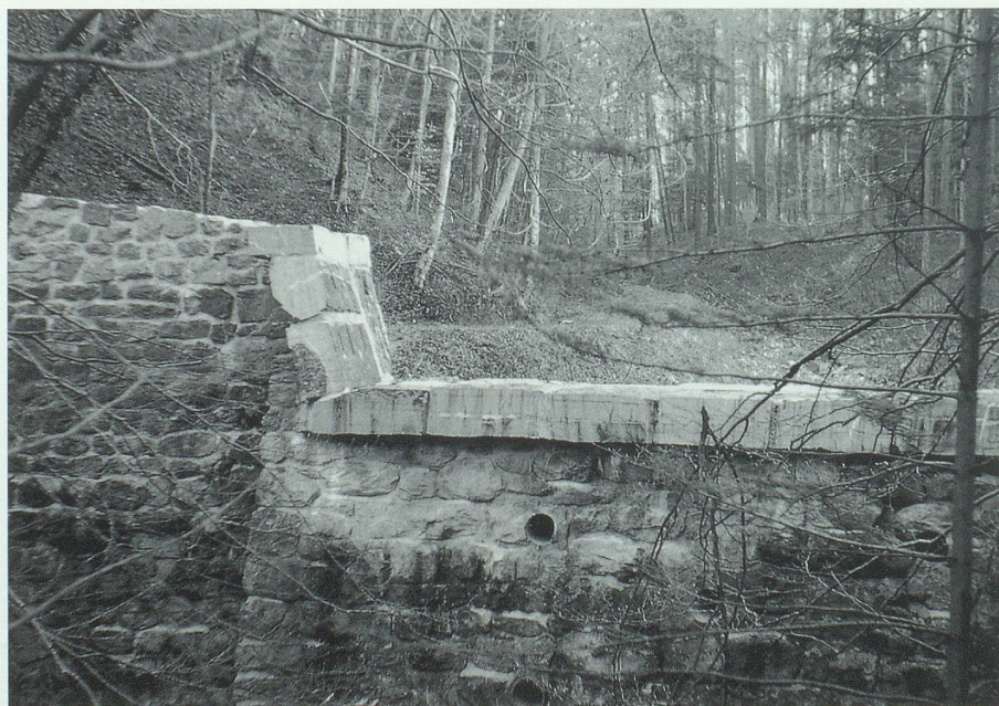
Die 1917 erbaute Rückhaltewand am oberen Ende des Geissbergtobels (Sevelerbach) wurde 1997 saniert und erfüllt ihren Zweck weiterhin. Bild: Eugen Henauer, Buchs.
