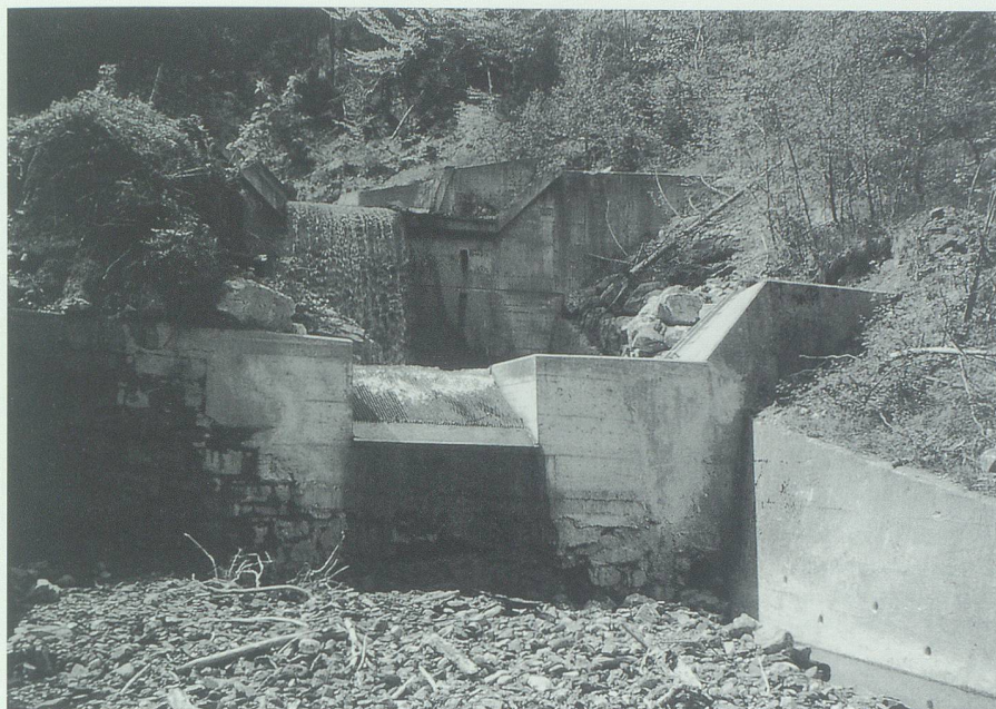
Die neue Fassung im Sevelerbach für das Elektrizitätswerk musste durch massive Mauern geschützt werden. Bild: Eugen Henauer, Buchs.
