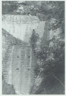
Mit Steinen verkleidete Betonmauern erlauben grössere Dimensionen, verlangen aber eine sorgfältige Mauerwerkarbeit. Trüebbach, Wartau. Bild im Baudepartement des Kantons St.Gallen, Sektion Wasserbau.
