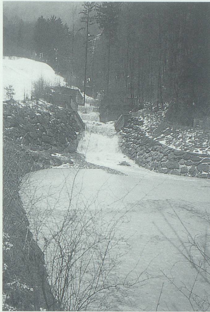
Verbauungen und Kiesfang im Studnerbach beim Obergatter (Grabs). Bild: Andreas Gasenzer, Grabs.
