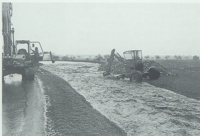
Der Einlauf des Saxer Mülbachs in den Kiesfang musste unter Einsatz von mehreren Baggern von Geschiebe freigehalten werden. Bild: Hans Jakob Reich, Salez.
