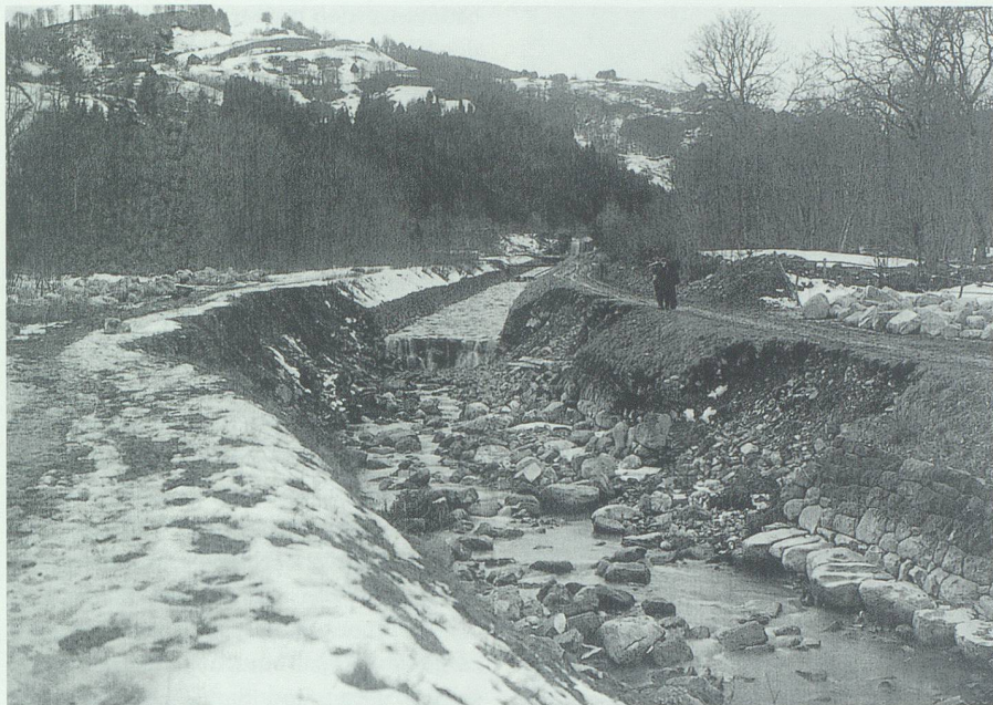
Schäden an der bereits korrigierten Simmi bei Gams, vermutlich verursacht durch das Hochwasser vom 23. bis 25. Dezember 1918. Bild im Staatsarchiv St.Gallen.
