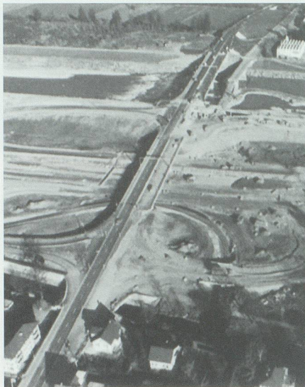
Der Anschluss Buchs im Oktober 1977: Die Notbrücke über den Rhein ist teilweise abgebrochen, Dammschüttungen sowie Trasse und Rampen des Autobahnanschlusses sind kurz vor der Fertigstellung; noch in Arbeit sind Fahrbahn und Brücken der Unterführung beim Kanalweg. Bild: Baudepartement des Kantons St.Gallen.
