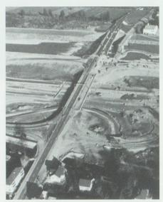
Der Anschluss Buchs im Oktober 1977: Die Notbrücke über den Rhein ist teilweise abgebrochen, Dammschüttungen sowie Trassee und Rampen des Autobahnanschlusses sind kurz vor der Fertigstellung; noch in Arbeit sind Fahrbahn und Brücken der Unterführung beim Kanalweg. Bild: Baudepartement des Kantons St.Gallen.
