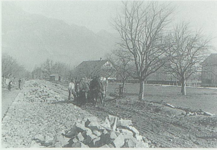
Sanierung der Strasse Grabs-Gams im Jahr 1933: Ein Steinbett wird eingebracht.
