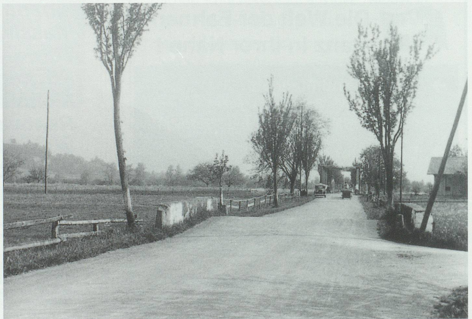
Die noch nicht geteerte Staatsstrasse bei Salez/Bremstel im Jahr 1933 mit den damaligen Brücken über den Leimbach (vorne) und den Werdenberger Binnenkanal (hinten).
