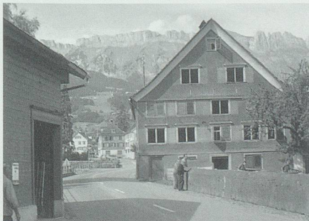
Grabs: Links die Remise Grob, Eisenwaren; rechts ehemalige «Linde» des Christian Eggenberger, Bezirksammann. Beide Objekte kurz vor dem Abbruch im Jahr 1968.
