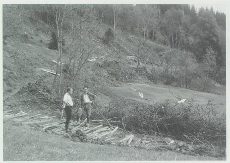
Waldstrassenbau «Oberschwendi III» im Lauizug Fadura in Gams (1966). Damit mit dem Trax gearbeitet werden konnte, musste der Baugrund (Flyschboden) mit Prügellagen stabilisiert werden.
