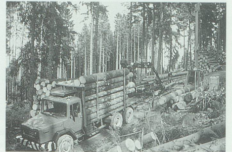
Abtransport von Sturmholz (Vivian 1990) über die Waldstrasse Cholbenböden in Grabs. Heute werden hierfür mobile Seilkrane (rechts) und Lastwagen eingesetzt.
