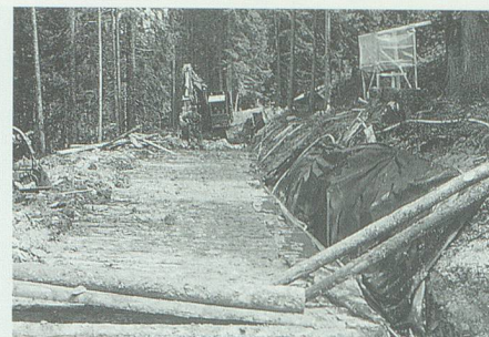
Bau der Hertistrasse in Grabs 1990 mit Prügelrost und Sickerleitung.
