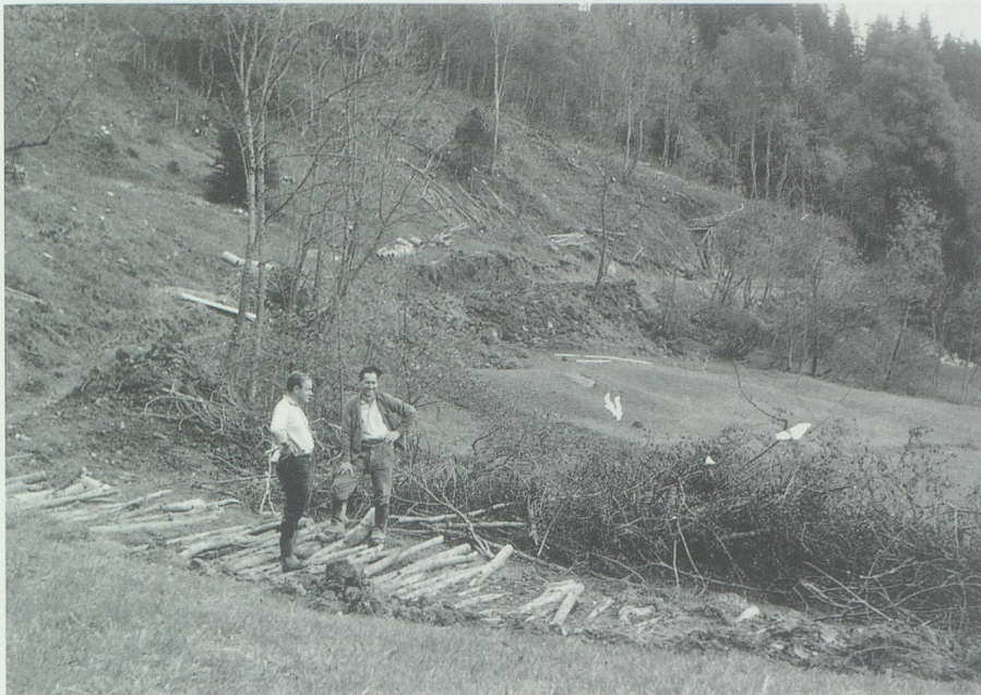
Waldstrassenbau «Oberschwendi III» im Lauzug Fadura in Gams (1966). Damit mit dem Trax gearbeitet werden konnte, musste der Baugrund (Flyschboden) mit Prügellagen stabilisiert werden.
