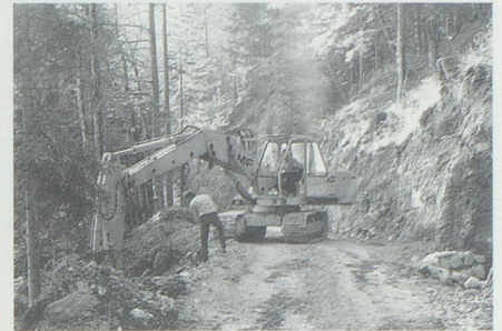
Beim Bau der Hübschenwaldstrasse 1988 in Sax.
