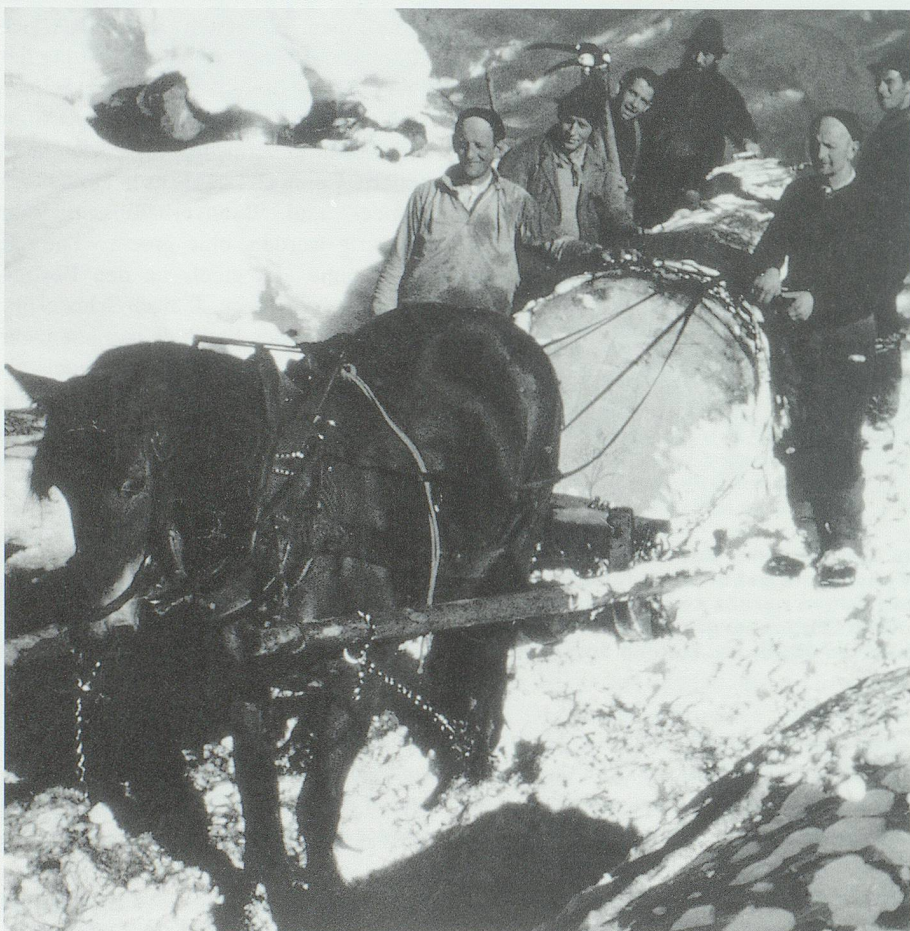
Abb. 26. Mit dem «Handtuu"s» führte ein Holzer einen Baumstamm auch durch gefährliches Gebiet talwärts. Der an der rechten Kufe und «Nase» befestigte Sparren diente der Steuerung des Gefährts. Das Bild, auf Prestenegg, Studnerberg, entstanden, zeigt Hans Vetsch (1896–1966), «dr Stutzis Hans». Er war so durch die steile Läui herabgekommen. Bild bei Mathias Vetsch, Obergatter, Grabs.
