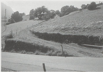
Abb. 12. Am Schnittpunkt der Strasse mit der Amatüegass (oberhalb des neuen Schulhauses) zeugt eine sorgfältig gestaltete Anfahrt mit schönen Bruchsteinmauern von der handwerklichen Kunst der Strassenbauer vor 100 Jahren. Bild 1996: Hans Stricker, Leversberg, Grabs.
