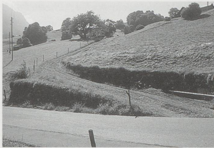
Abb. 12. Am Schnittpunkt der Strasse mit der Amatüeggass (oberhalb des neuen Schulhauses) zeugt eine sorgfältig gestaltete Anfahrt mit schönen Bruchsteinmauern von der handwerklichen Kunst der Strassenbauer vor 100 Jahren. Bild 1996: Hans Stricker, Leversberg, Grabs.
