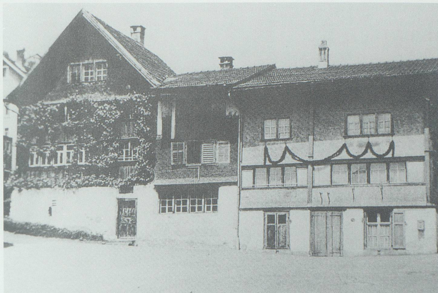
Das 1965 abgebrochene Haus «Tirolers» (links) auf der Bsetzi war der mündlichen Überlieferung zufolge ein ehemaliges Zollhaus. Bild in der Sammlung Karl Haldner, Gams.
