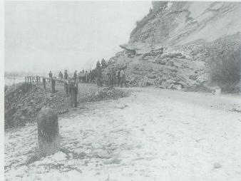
Abb. 19/20. Am 15. Dezember 1912 wurde die Schollbergstrasse im Bereich des späteren Steinbruches von einem Felssturz verschüttet. Bild links: Friedrich Müller, Buchs (im Strassenkreisinspektorat Buchs). Rechts: Räumarbeiten nach dem Felssturz im Dezember 1912. Bild im Staatsarchiv St.Gallen.
