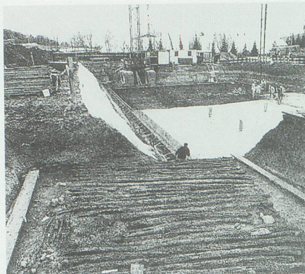
Abb. 5. Hölzerner Unterbau der römischen Strasse bei Otelfingen ZH. Bild: Kantonsarchäologie Zürich.
