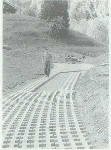
Steile Wegstrecken erhielten wegen der erhöhten Ausschwemmgefahr entweder Hartbeläge oder, wie hier, einen Schutz mit Rasengittersteinen. Die fortlaufende, rechtzeitige Behebung auch kleinster Strassenschäden, zum Beispiel auch das Ausräumen der Querriegel nach Gewittern, erspart später grosse Unterhaltskosten. Bild: FKL & Partner, Grabs.
