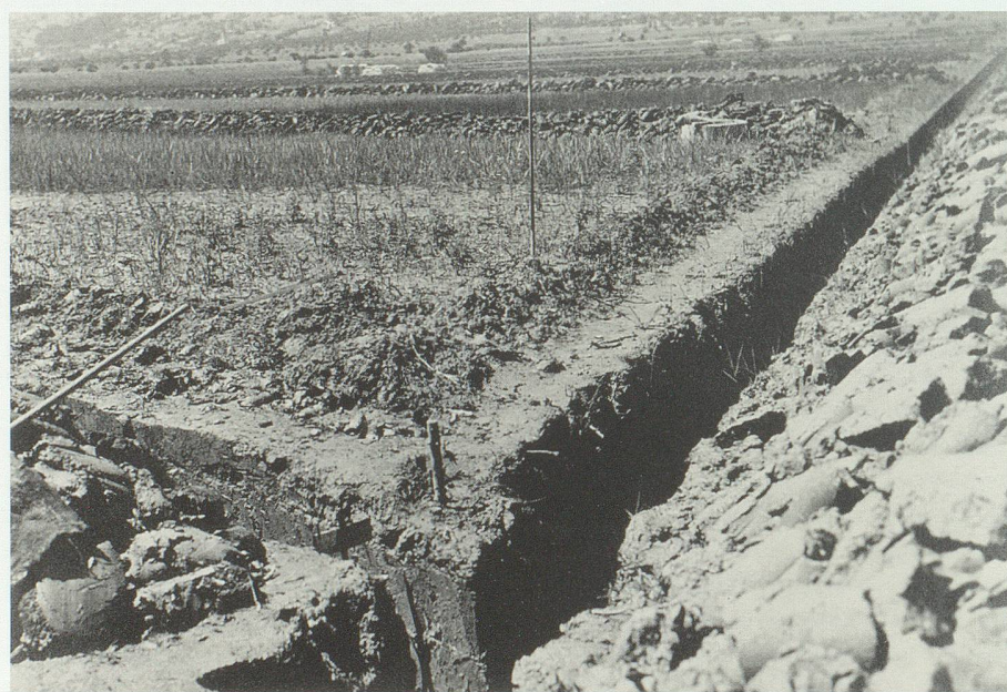
Abb. 35/36. Oben: Meliorationsarbeiten auf dem Areal der Strafanstalt im Bereich der Bahnlinie. Links: Gräben für die Drainage. Bilder in Privatbesitz.
