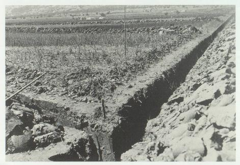
Abb. 35/36. Oben: Meliorationsarbeiten auf dem Areal der Strafanstalt im Bereich der Bahnlinie. Links: Gräben für die Drainage. Bilder in Privatbesitz.
