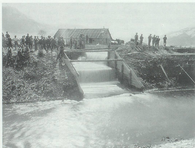
Abb. 26. Bereits um 1884 war die Simmi dem um jene Zeit gebauten Werdenberger Binnenkanal zugeführt worden; ihr Unterlauf, der bei Salez direkt in den Rhein gemündet hatte, wurde bei der Güterzusammenlegung Haag (1885–1887) zum Teil zugeschüttet. Bild bei Noldi Kessler, Gams.
