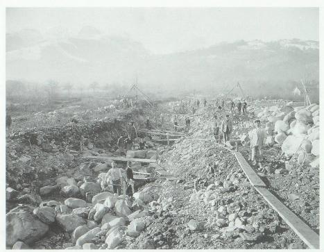
Abb. 24. Die Korrektion der Simmi war Voraussetzung für die Güterzusammenlegung im Gamser Simmigebiet von 1900–1905. Wie beim Grabserbach mussten mit grossem Aufwand die alten Dämme abgetragen und das Gelände planiert werden. Bild bei Noldi Kessler, Gams.
