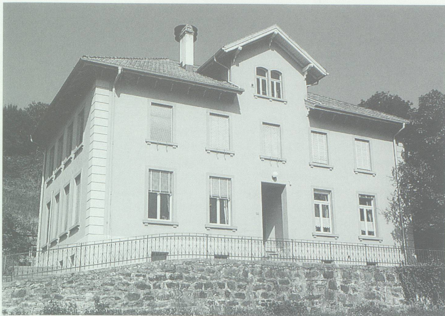
Abb. 18. Das Ranser Schulhaus von 1900/01. Zustand 1994.
