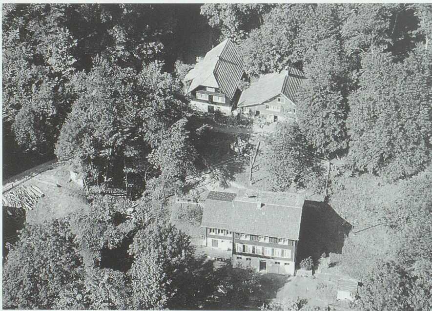
Abb. 16. Das Schulhaus auf der Steig von 1892 (vorne); oben links das alte von 1818. Zustand 1994.
