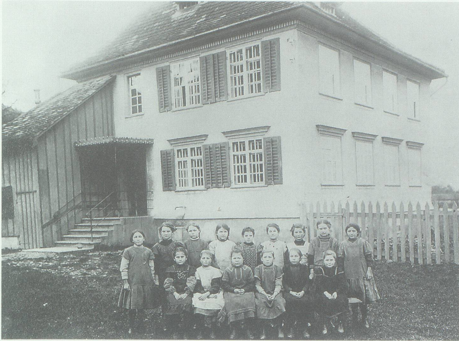
Abb. 21. Das Schulhaus Altendorf, erbaut 1883, auf einer Fotografie von 1913.
