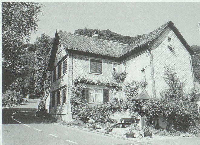
Abb. 7. Das frühere Schulhaus von Weite. Zustand 1994.
