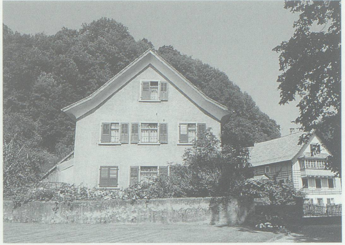
Abb. 10. Das ehemalige Schulhaus von Gretschins, gebaut 1843. Zustand 1994.
