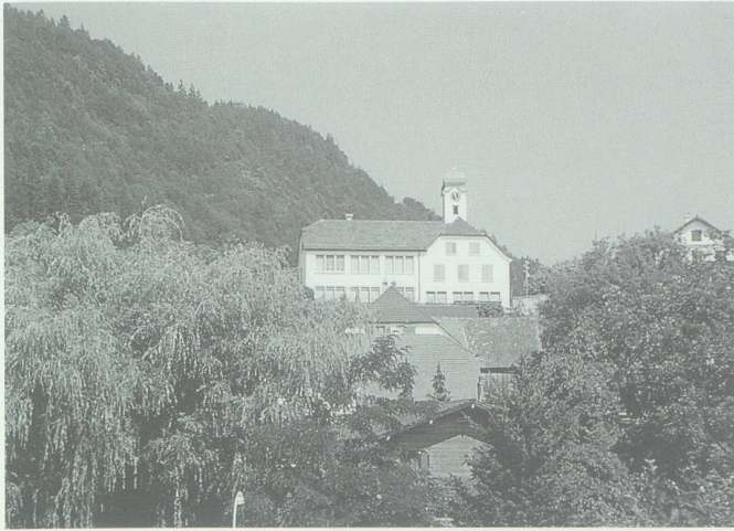
Abb. 9. Das Schulhaus von Oberschan, 1822 errichtet an der Stelle der einstigen St.Oswaldkapelle. Zustand 1994.
