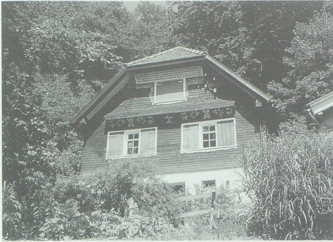
Abb. 14. Das alte Schulhaus Steig (Sevelerberg) von 1818. Zustand 1994.
