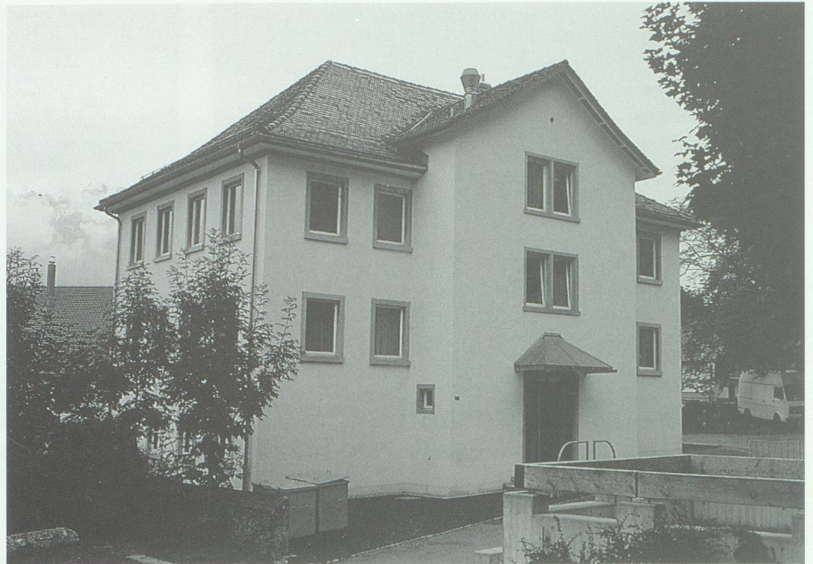
Abb. 17. Das Schulhaus Stampf in Sevelen, gebaut 1837/38. Zustand 1994.
