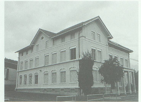
Abb. 25. 1912 wurde das Grofschulhaus erweitert, 1939 führte eine Aussenrenovation zu einer Veränderung des Aussehens. Zustand 1994.
