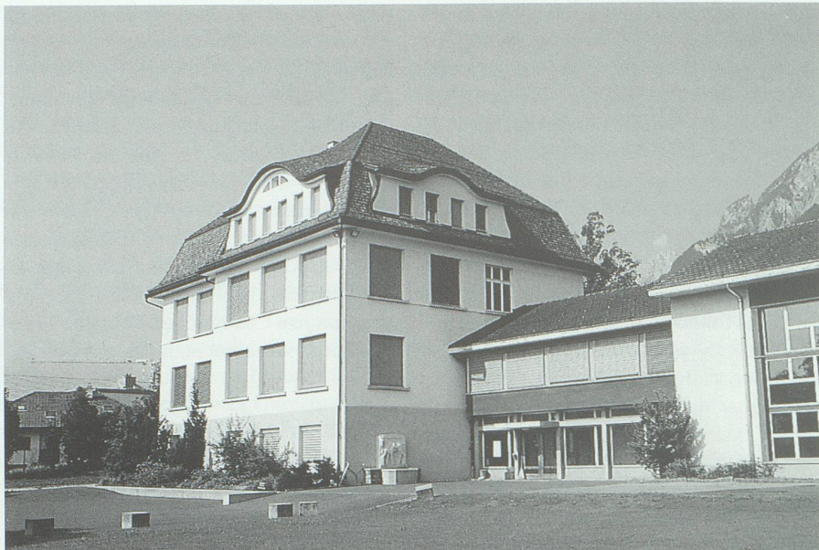
Abb. 43. Das 1913 fertiggestellte zweite Sennwalder Schulhaus. Zustand 1994.
