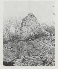
mäuers waren völlig lose und wurden nur durch Efeubewuchs zusammengehalten. Die Mauerfugen wurden mit einem frostsicheren Mörtel gestopft, und die Mauerkrone erhielt eine armierte Abdeckung.
