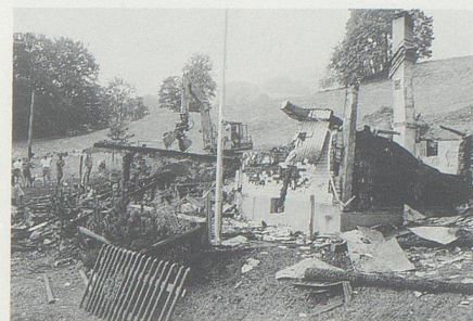
29. Juli: Von Stall und Wohnhaus am Verlorenen Berg, Sevelen, bleibt nach einem Brand nur noch wenig übrig.
