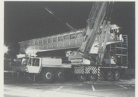
19./20. Dezember: Für die Autobahnraststätte Werdenberg bei Sevelen wird eine Holzbrücke über die N13 montiert.
