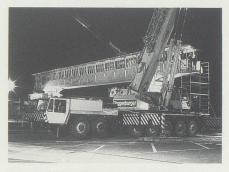
19./20. Dezember: Für die Autobahnraststätte Werdenberg bei Sevelen wird eine Holzbrücke über die N13 montiert.
