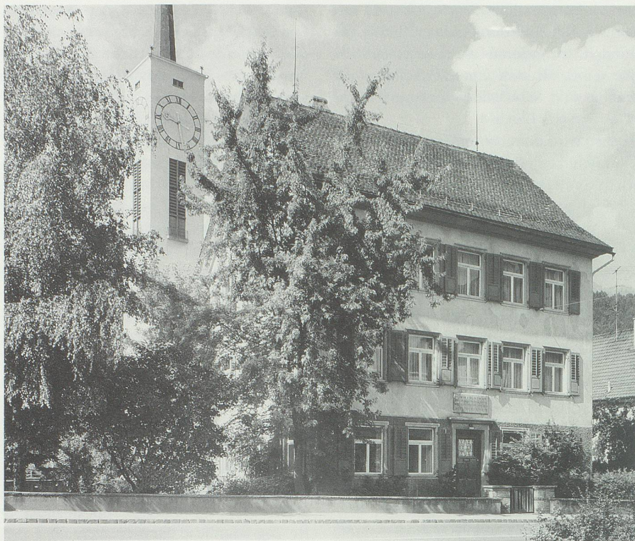
Rohrers Geburtshaus vor der Renovation. Die Gedenktafel trägt die Inschrift: «Am 30. April 1848 wurde in diesem Hause geboren: Der Liederdichter und Arzt Dr. Friedrich Rohrer». (Bild im Besitz von Hansruedi Rohrer, Buchs.)
