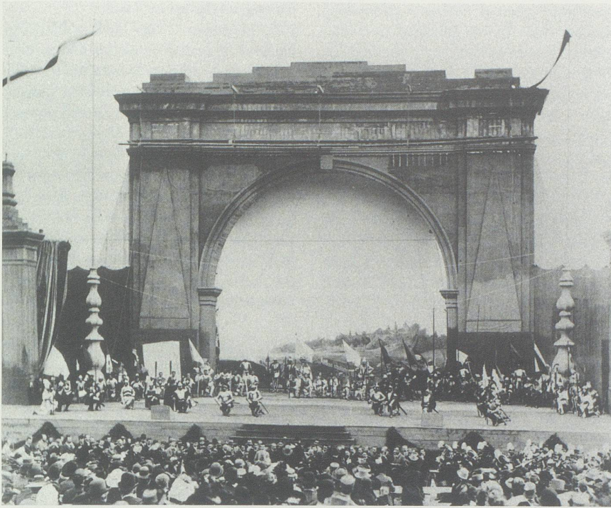
Für das Festspiel an der eidgenössischen Bundesfeier in Schwyz von 1891 wurde dieser pompöse Triumphbogen aufgebaut. (Aus Hauser 1989, S. 374.)
