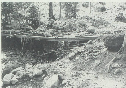
26. Juni: Nach dem Unwetter in Sax: Die zerstörte Brücke des Zufahrtsweges zum Berggut Au.
