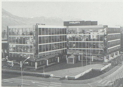
25. November: Das neue Hilti-Bürohaus bei der Rondelle in Buchs.
