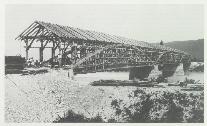
Die Brücke Salez–Ruggell kurz vor ihrer Fertigstellung im Jahre 1929. Nach der Verkleidung mit Schirmbrettern sah diese Bogenbrücke nach System Tuchscherer äusserlich gleich aus wie die Howeschen Fachwerkkonstruktionen. Die beiden Pfeiler wurden betoniert. (Bild: Landesbauamt Vaduz.)
