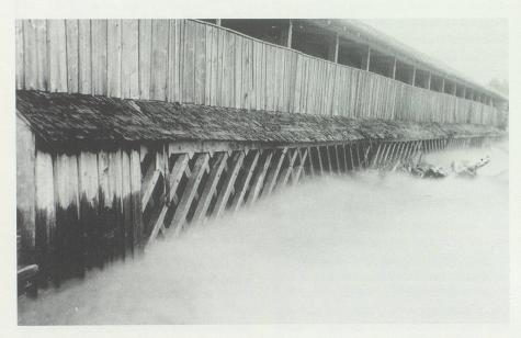
Die Buchser Holzbrücke kurz vor dem Einsturz. Durch Entfernen der Verschalungen hatte man versucht, die Brücke zu retten.
