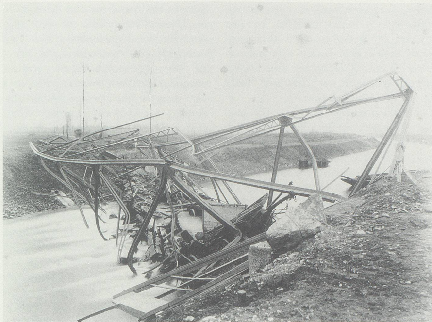
Bei der Belastungsprobe stürzte die Kanalbrücke bei Salez ein, wobei mehrere Fuhrwerke in Brüche gingen. Aufnahme vermutlich Ende 1885. (Bild: Staatsarchiv St.Gallen.)
