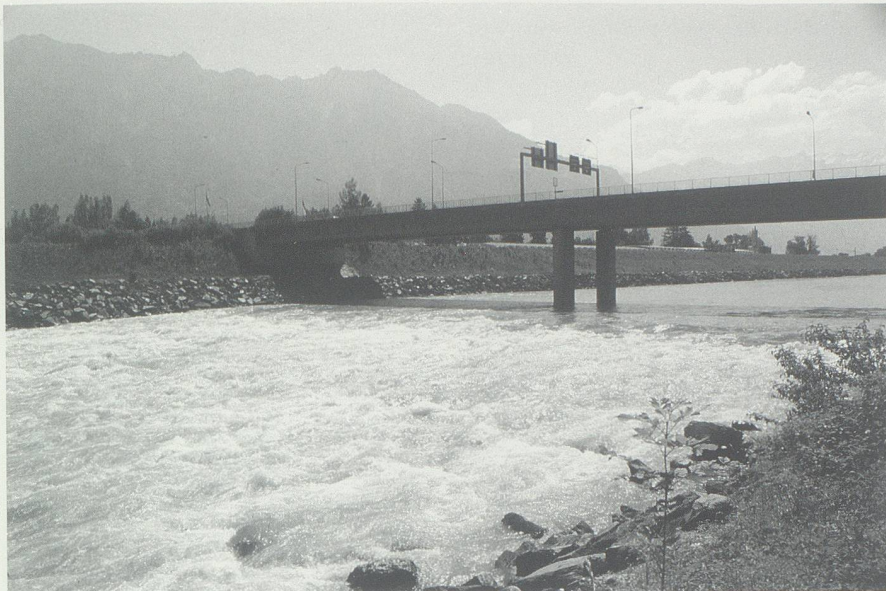
Die 1971 errichtete Blockschwelle bei Buchs. (Bild: Hans Jakob Reich, Salez.)
