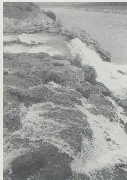
Die heutige, verlegte Saareinmündung nördlich von Trübbach. Gut sichtbar der beträchtliche Niveau-Unterschied infolge Absenkung der Rheinsohle. (Bild: Otto Ackermann, Fontnas.)
