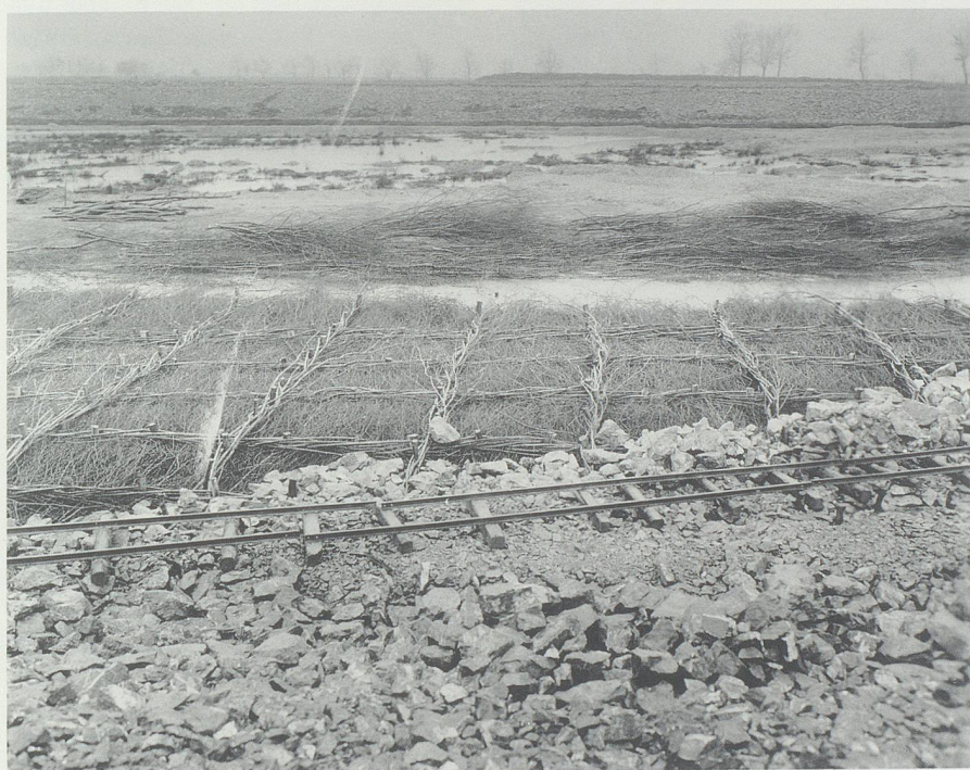
Wie hier beim Diepoldsauer Durchstich im Jahr 1913 dürfte auch am Werdenberger Rheinabschnitt für den Dammbau Faschinenwerk verwendet worden sein. (Bilder: Staatsarchiv St.Gallen.)
