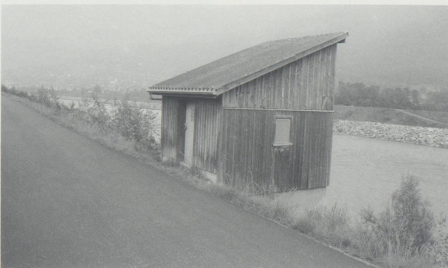
Das heute als Wasserstands-Messstation genutzte frühere Schleusenhäuschen bei Weite. (Bild: Otto Ackermann, Fontnas.)
