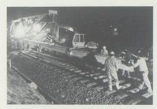
1./2. April: Die Bauarbeiten für die Bahnunterführung Bühel in Salez sind im Gange. Über Nacht wird eine Notbrücke erstellt.
