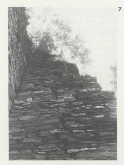
Augenfälligstes Zeichen, dass baldige Hilfe nottut, ist ein langer, vertikaler Riss in der südlichen Turmwand (7, Foto 1987).
