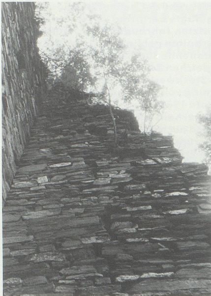
Augenfälligstes Zeichen, dass baldige Hilfe nottut, ist ein langer, vertikaler Riss in der südlichen Turmwand (7, Foto 1987).
