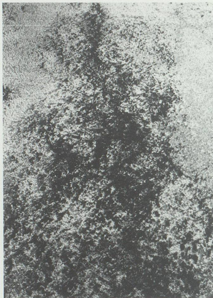
Der intensive Pilz- und Algenbewuchs am Turm bedingte die Gesamterneuerung des Verputzes.
