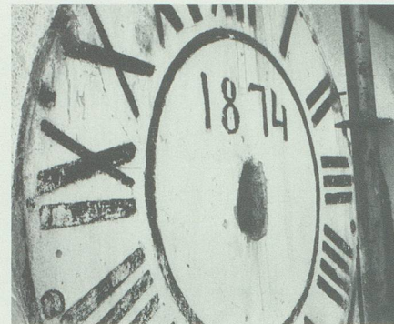
1874 installierte man eine Turmuhr. Auf der Süd- und der Nordseite malte man einen einfachen Ziffernkranz auf den Verputz.
