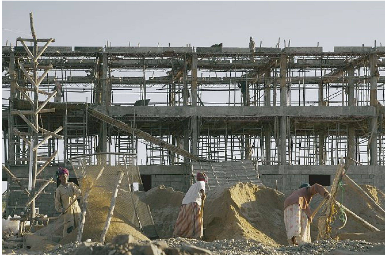
Bauarbeiten für den Campus in Axum
