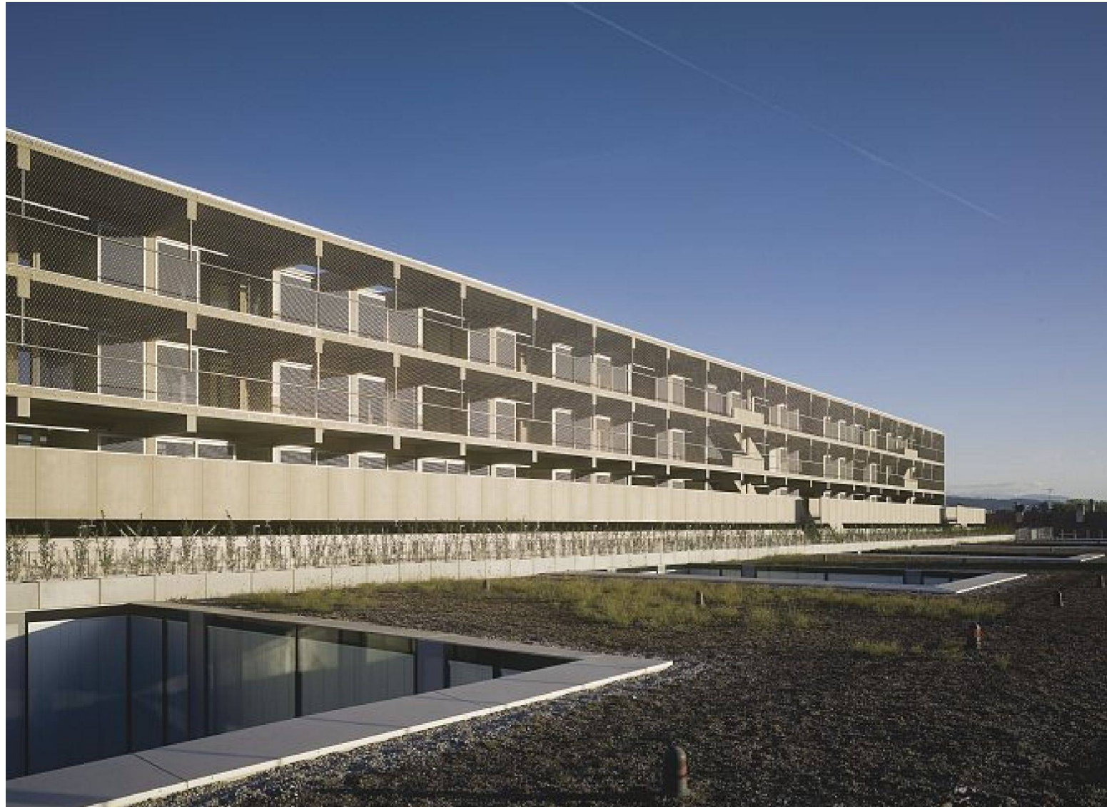
Gesamtansicht der Wohngeschosse vom Dach des Bürobaus aus. – Bild: Architekturfotografie Gempeler, Bern
