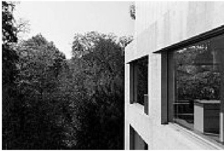
Tiefe, eingeschrägte Leibungen
