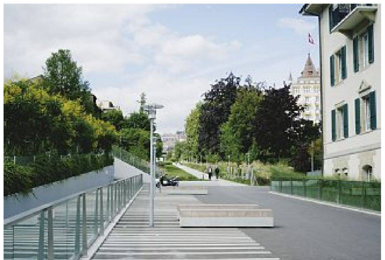
Station Jordils, Blick Richtung Norden, Richtung Stadt
