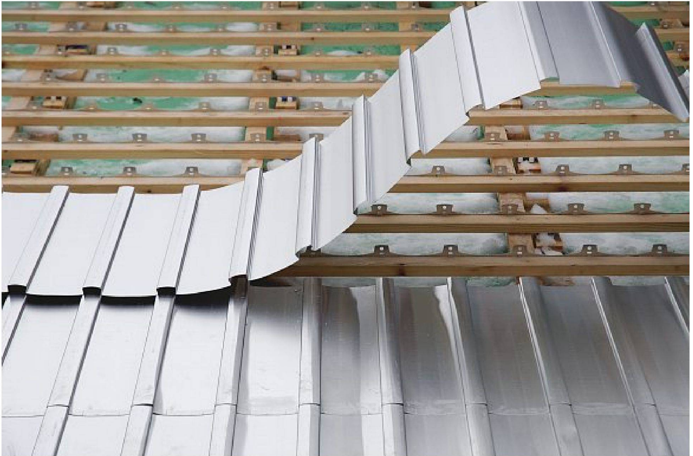
Montage des neu hergestellten Furalbandes auf dem Dach der Schulanlage Untermos. Durch das Abrollen verkrallt sich das Blech mit der identisch profilierten Unterkonstruktion und hält ohne weitere Verschraubungen. – Bild: Roger Frei
