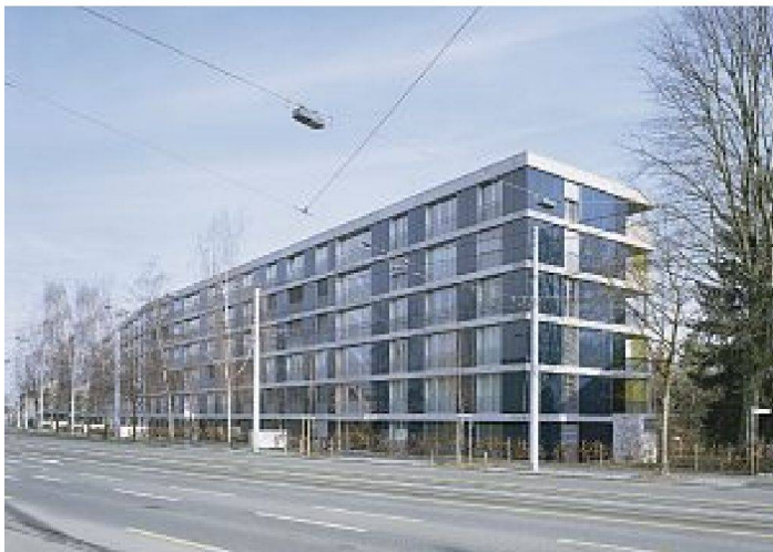
Strassenfassade entlang der Hofwiesenstrasse
