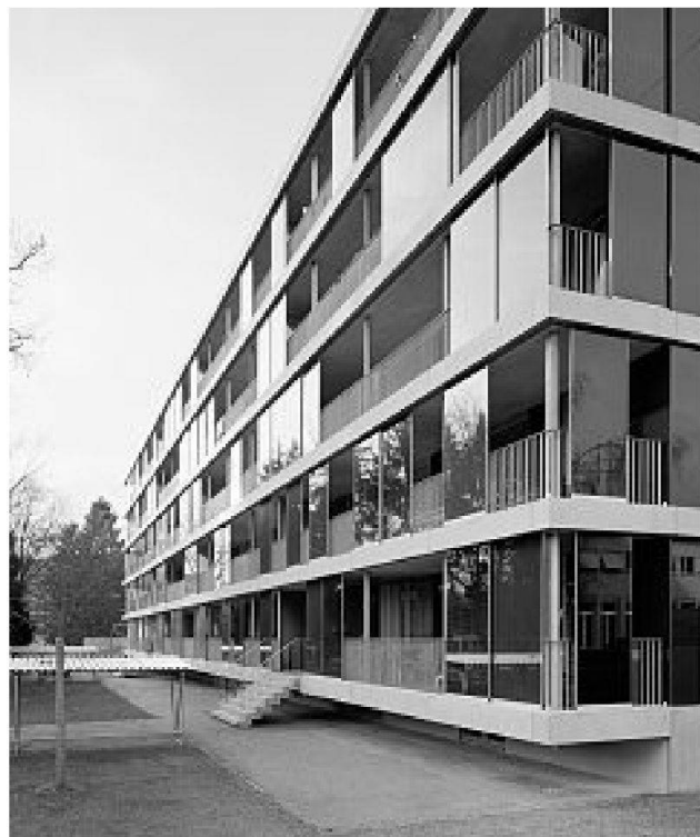
Parkseite, verschiebbare Glaselemente
