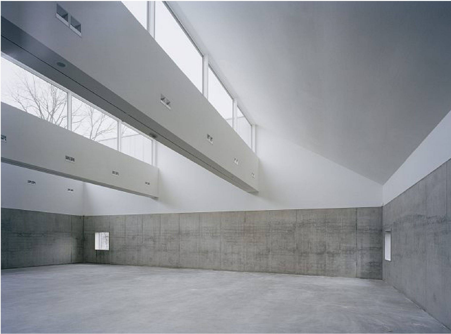
Nach Norden ausgerichtetes Sheddach und Wände aus Beton: der Saal für die Sammlung im obersten Geschoss
