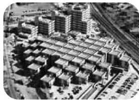
Herman Hertzberger, Bürogebäude Apeldoorn
