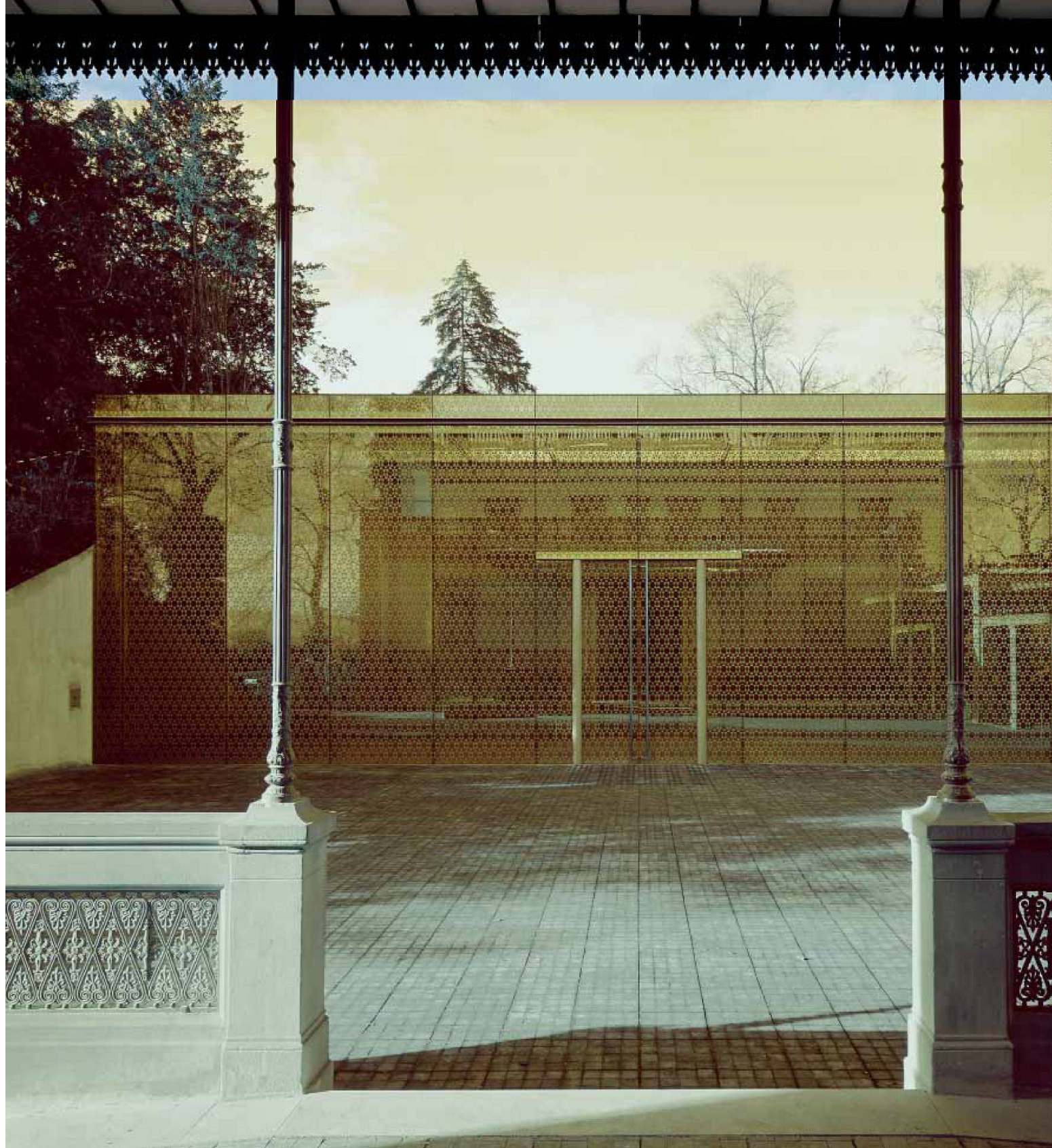
Eingangspavillon vom Eingang der Villa aus gesehen. Rechts: Ehemalige Villa Wesendonck, erbaut 1853-1857.
