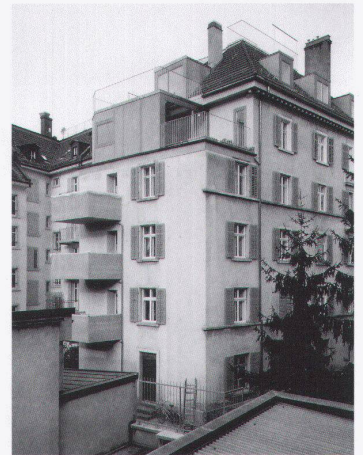
rechts: Umbau und Dachaufbau Josefstrasse Zürich, von Ballmoos Krucker Architekten 1997. Verarbeitung der Duripanelplatten in unregelmässigen, Restezulassenden Breiten. – Bild: Georg Aerni Grundriss oben und Bilder unten: Assisted Self-build housing, Tilbury 2001–2003. Bilder: David Grandorge
